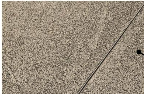
Trottoirs en béton désactivé
