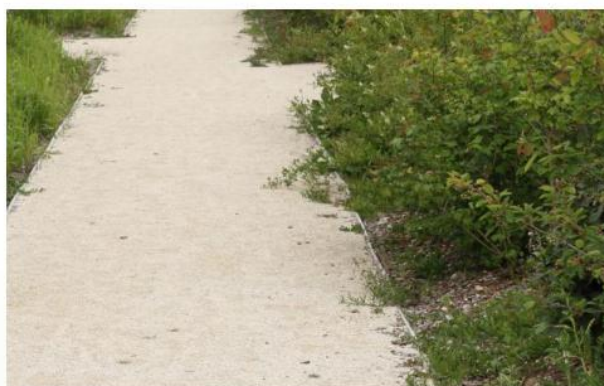
Cheminement en sablé stabilisé renforcé
