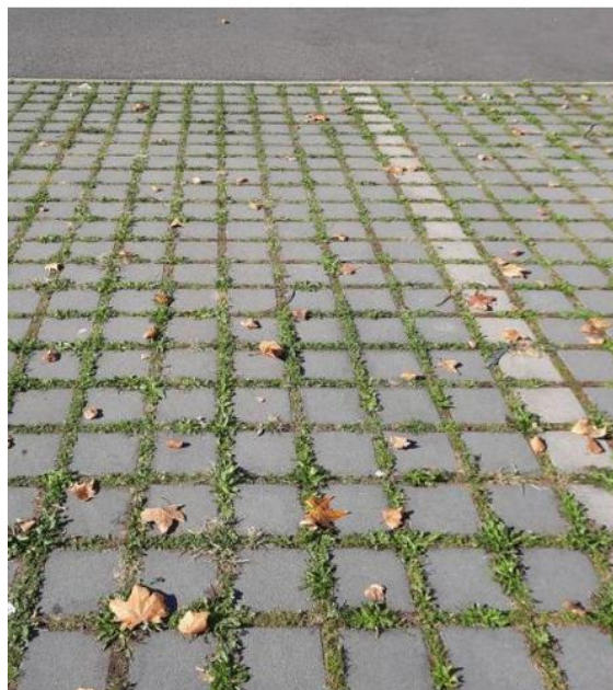
Parking en pavés joints gazon
