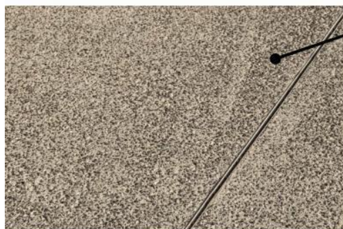
Trottoirs en béton désactivé
