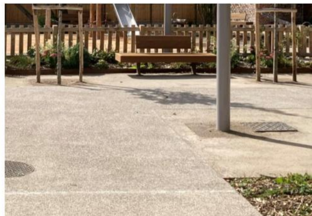
Parvis en béton micro désactivé
