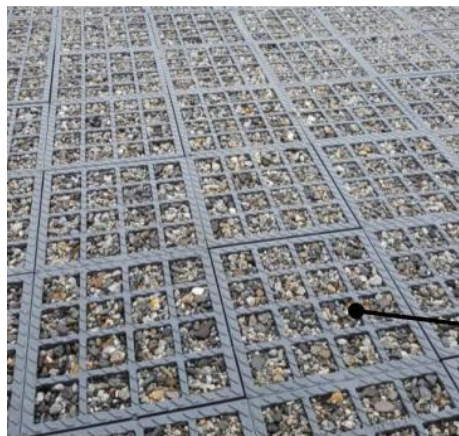
Entrées charretières en dalles gravillonnées
