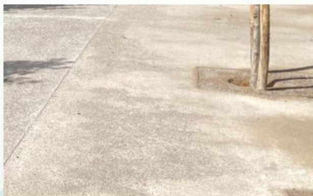
Cheminement en sablé stabilisé
