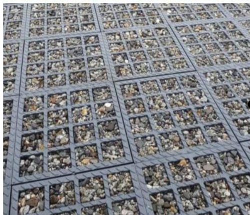
Entrées charretières en dalles gravillonnées
