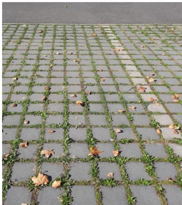
Parking en pavés joints gazon
