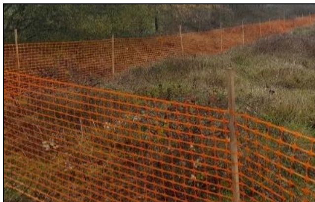
Illustration 10 : Exemples de filet de balisage en phase travaux
