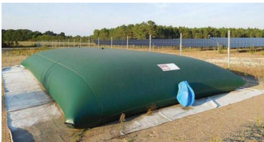
Illustration 7 : Exemple de citerne souple autoportante d'eau de défense incendie
