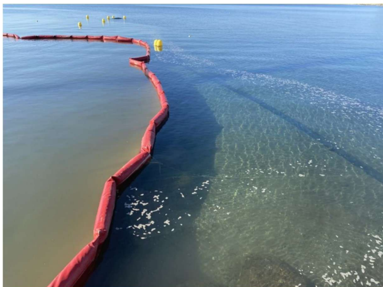
Photo 6 : Déploiement de filet anti MES
