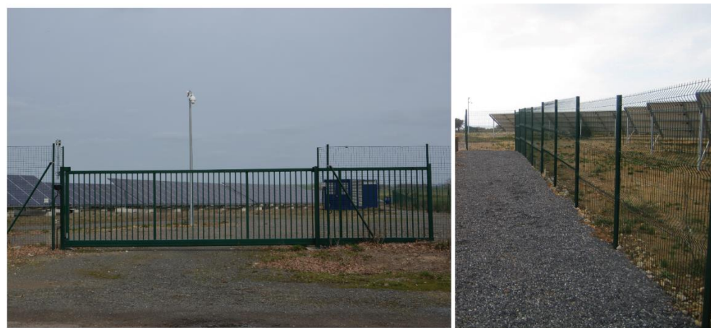
Photographie 5 : Exemple de clôture de sécurité et portail d'accès (Source : ENCIS Environnement)
