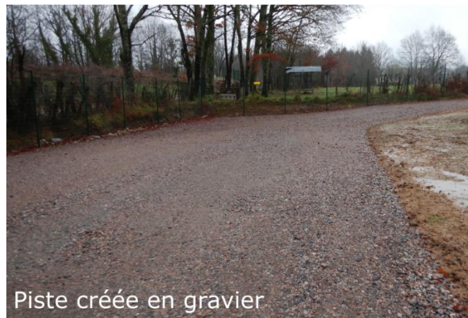
Photographie 4 : Exemple de pistes empierrées (Source : ENCIS Environnement)
