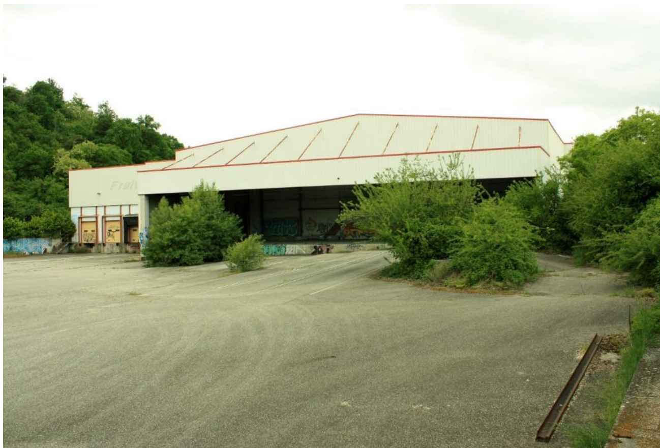
FIGURE 1 : VUE DE LA FAÇADE SUD DU BATIMENT FRUITCOOP
