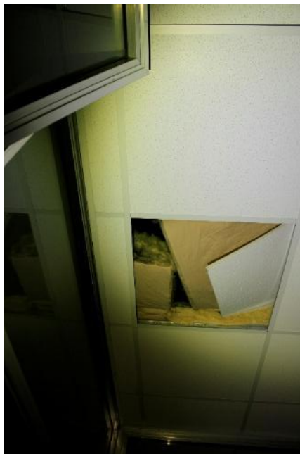
FIGURE 27 : PLAFOND OUVERT OFFRANT DES ACCES AUX TOITS
