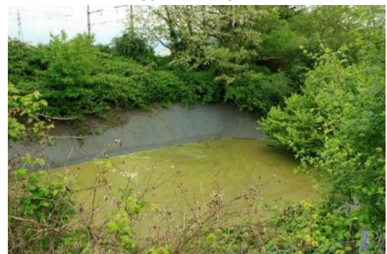
FIGURE 15 : BASSIN ARTIFICIEL DE STOCKAGE D'EAU
