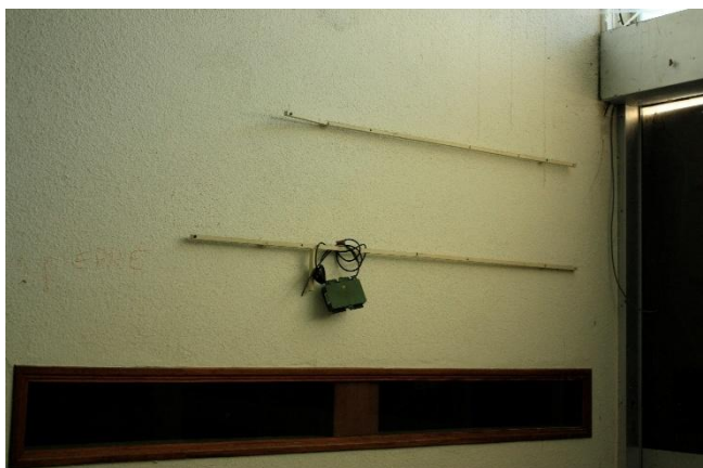
INSTALLATION D'UN BOITIER PASSIF SMBAT MINI AU SEIN DE L'AILE NORD-OUEST (18/08/2025)
