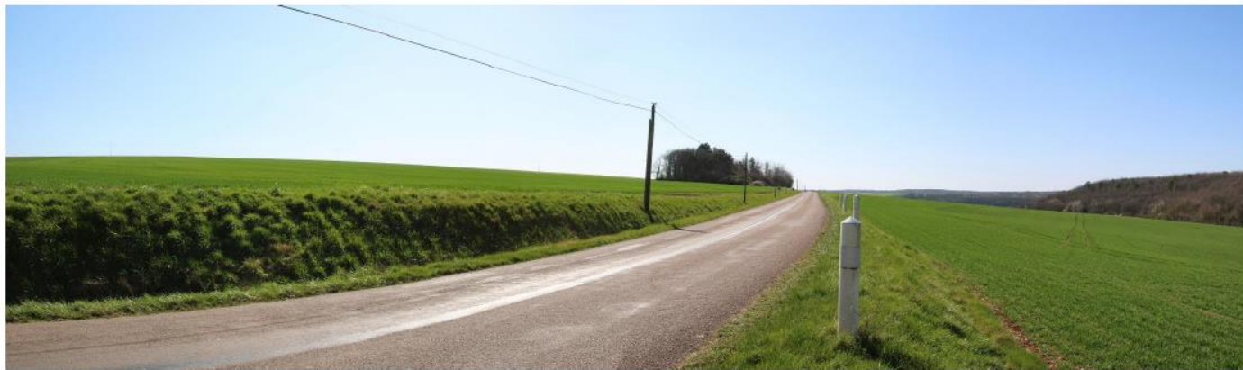
Photo 15. Etat initial depuis le point de vue n°1, sur la D443 à l'Est de Villemorien
