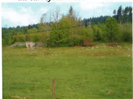
Ancien réservoir bordant la RD 48 au carrefour « des Plans »
