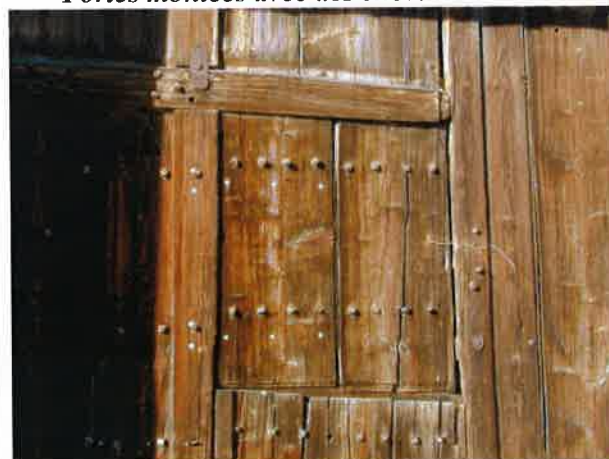
Portes montées avec des chevilles en bois
