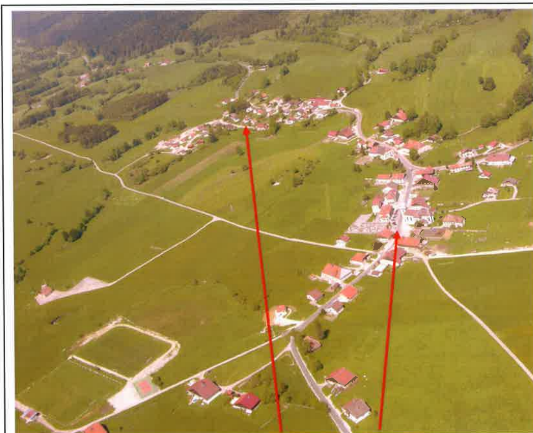
Vue aérienne sur la Chaux : « sa zone résidentielle », « son centre ancien à protéger »
