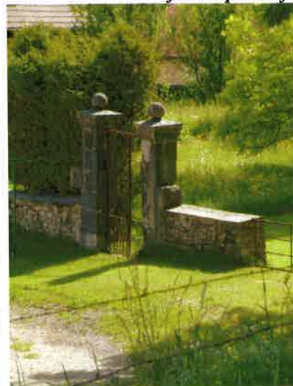
Mur et clôture de jardin privé
