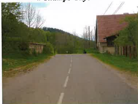
Ancien réservoir à l'alignement de la RD 48 « Champs Derrière » / « Champs Guyon »
