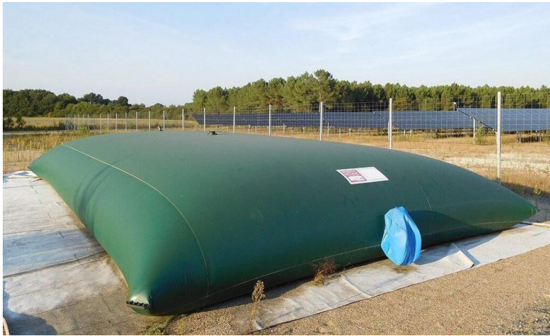
Figure 10 : Citerne incendie (source : maciternesouple.fr)
