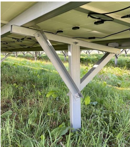
Figure 5 : Pieu battu (source : Siguesol)
