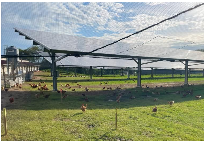
Figure 7 : Photographie d'une volière photovoltaïque Technique Solaire (47) dans le cas d'un élevage de poulets de chair, avec à gauche le bâtiment d'élevage relié directement aux panneaux solaires et à la clôture périphérique, formant un clos total.
