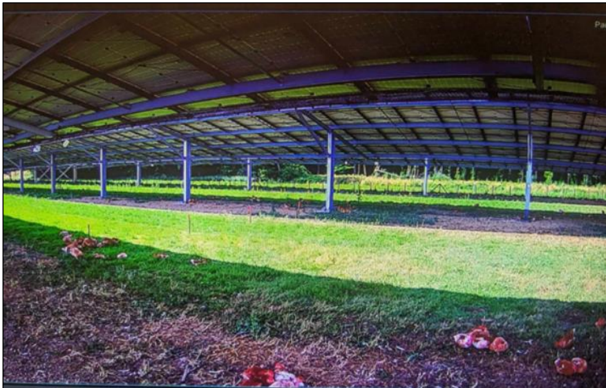
Figure 11 : Photographie du parcours extérieur lors d'un jour de forte chaleur ( T_{air} = 30^{\circ}\text{C} ) lors duquel les poulets fréquentent préférentiellement les zones d'ombre apportées par les panneaux solaires. Les zones ensoleillées sont désertées.
