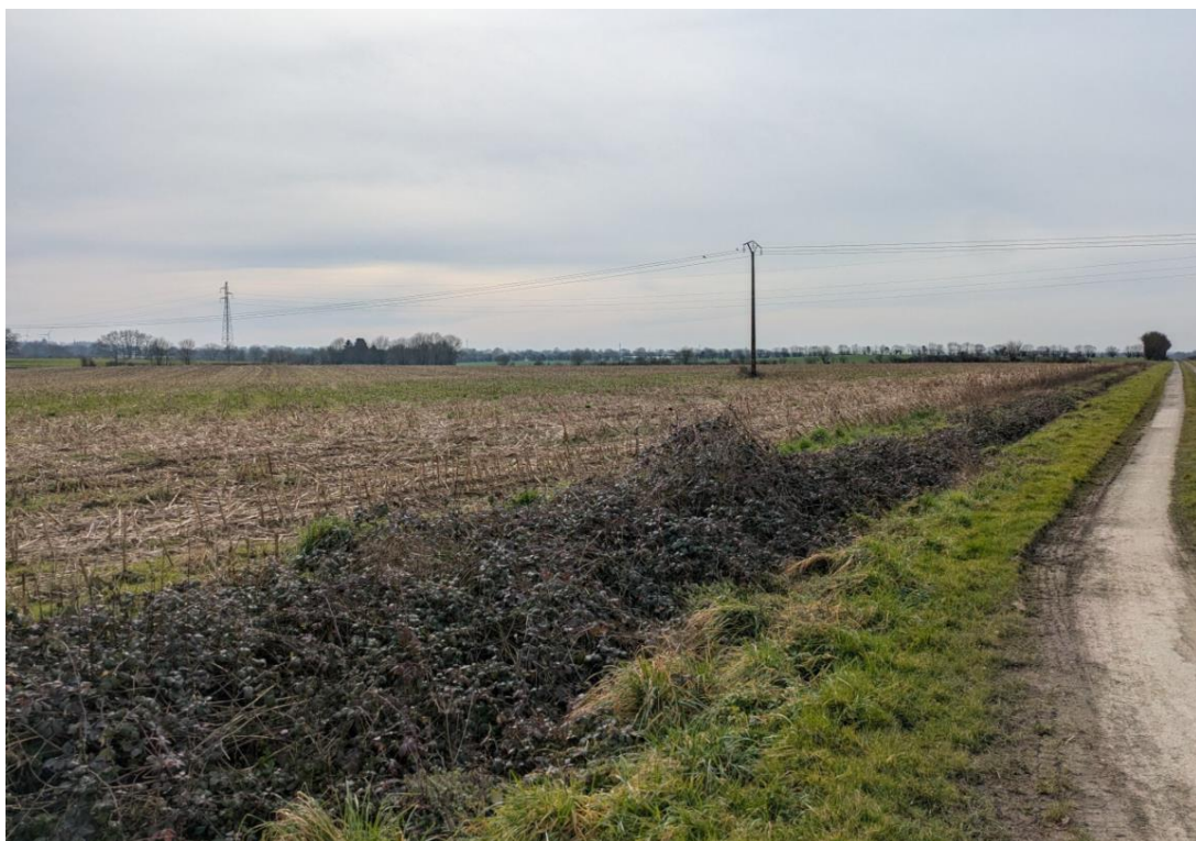
Vue de la ligne électrique HTA depuis le chemin d'accès au Nord-Ouest du projet
