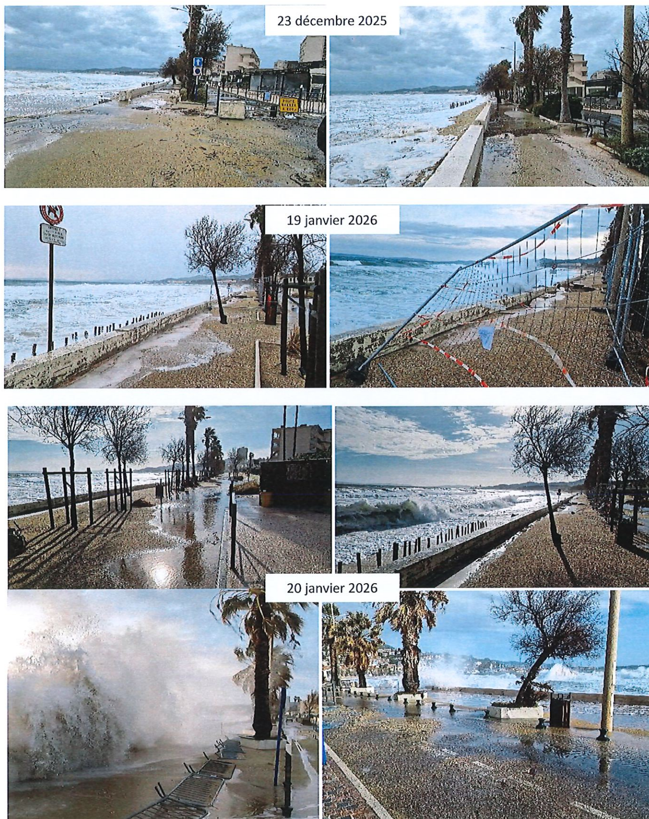
Figure 4 : Photographies du franchissement de la promenade, érosion de la plage et sollicitation du perré
