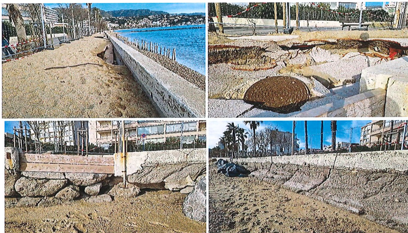
Figure 6 : Photographies de l'affaissement de la piétonne et de la fracturation du muret, 6 janvier 2026
