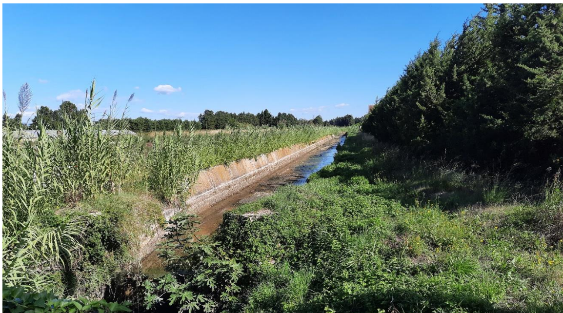
Figure 24. Démarrage du chemin d'exploitation au sud du canal des Alpes
