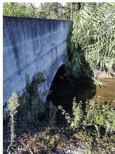
Figure 33. Deuxième point de traversée du canal des Alpines
