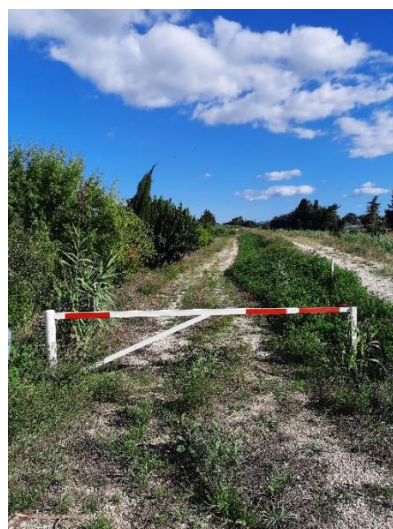
Figure 29. Suite du chemin au nord de la digue
