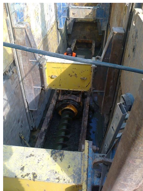
Figure 35. Exemple de réalisation d'un fonçage sous un cours d'eau
