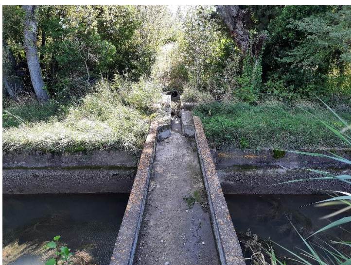
Figure 25. Passage du pluvial au droit du chemin d'exploitation
