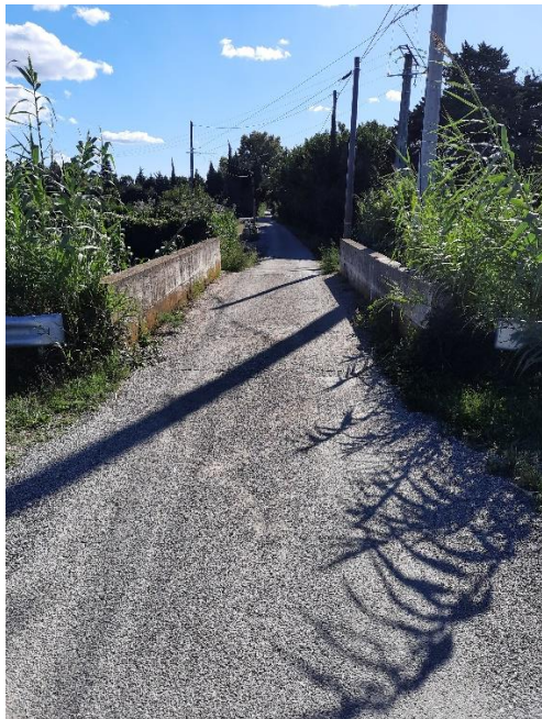
Figure 43. Chemin du Pont de Bois (passage du Canal)
