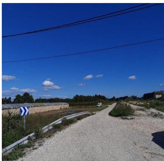
Figure 28. Démarrage du chemin au nord de la digue
