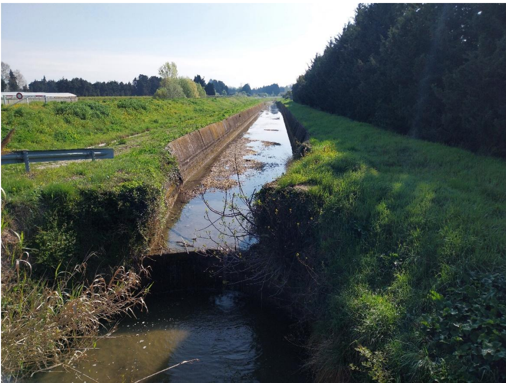
Photo 6 du canal des alpines au nord du champ captant
