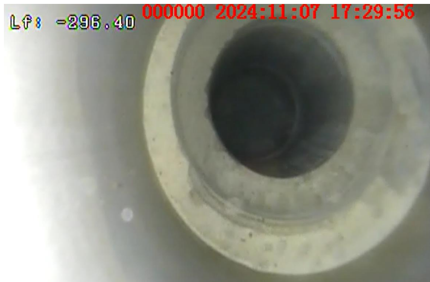
Figure 20: Etat du bouchon de ciment après premier passage au trillâmes.
