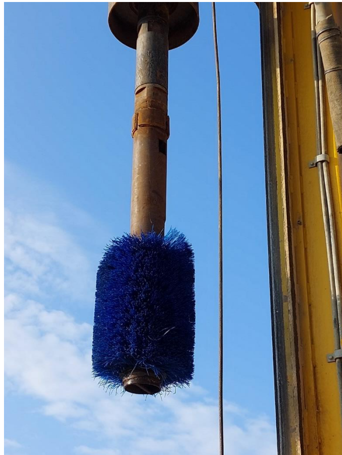
Figure 16: Brosse à poil souple utilisée pour le nettoyage des forages par action mécanique.
