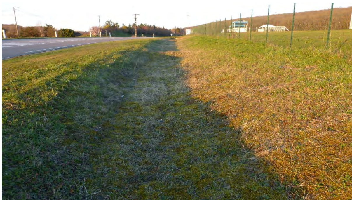
Fossé d'infiltration Ouest
