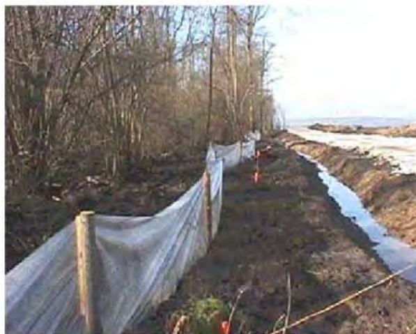
Exemple de barrière anti-amphibien en phase chantier
