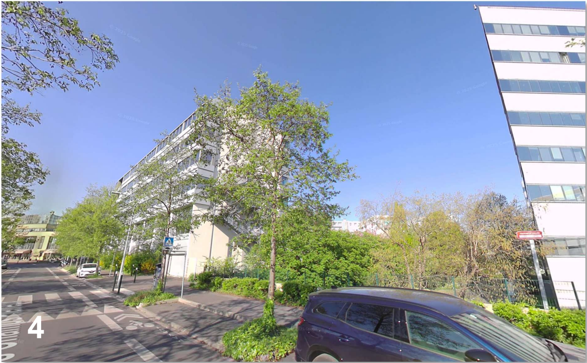
Vue en direction du site depuis l'avenue des Champs Pierreux à environ 140 m du site, à l'est
