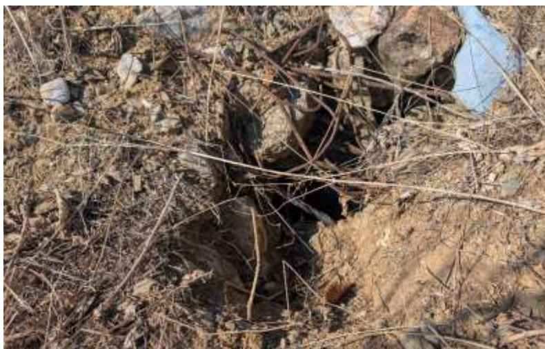
Photo 15 : Cavités observées dans le talus en friche au sud de la ZIP.
