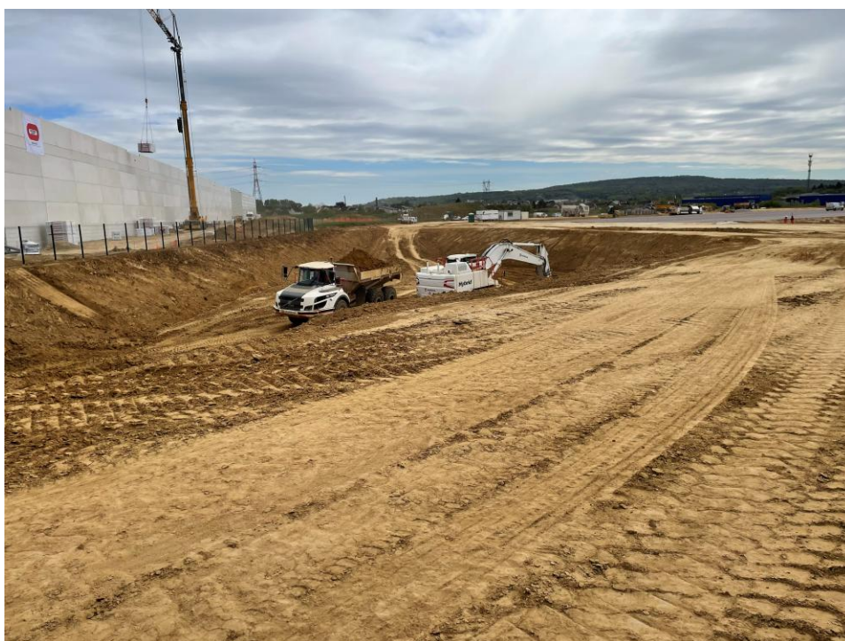
Figure 3 : Création du bassin de gestion des eaux pluviales en date du 15 avril 2026
