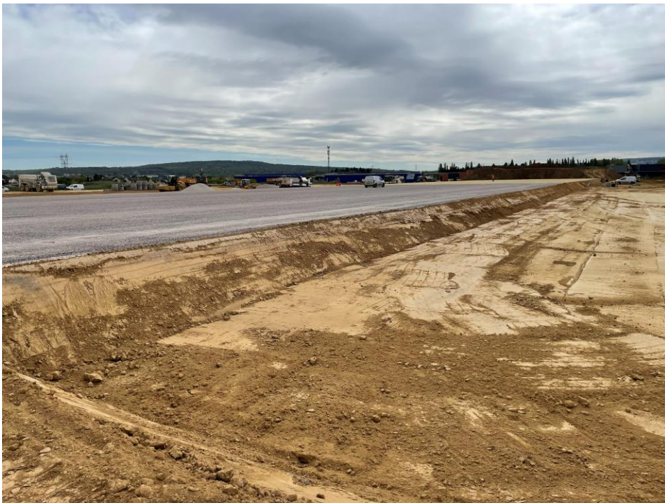
Figure 1 : Emulsion gravillonné de la plateforme de la messagerie en date du 15 avril 2026
