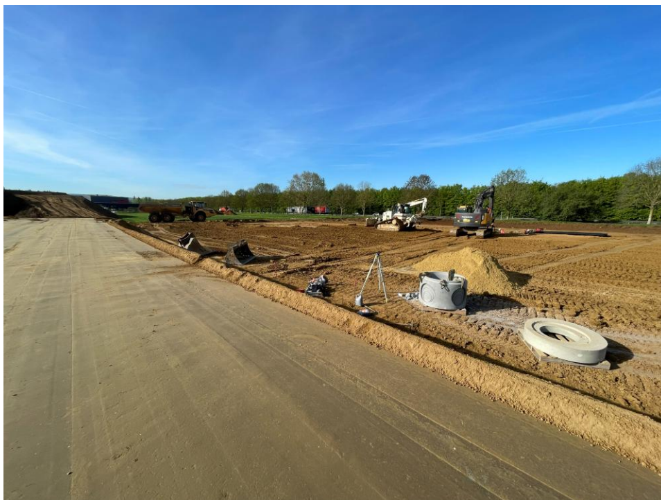
Figure 2 : Plateforme messagerie en attente de l'émulsion gravillonnaire en date du 15 avril 2026
