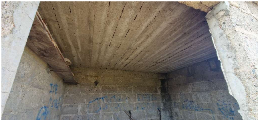
■ Photographie 9 : Intérieur du casot agricole au sein de l'aire d'étude
