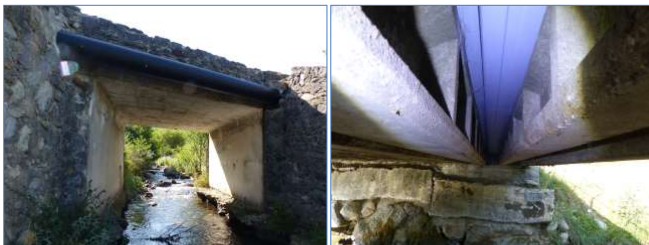
Pont entièrement maçonné (à gauche) ; pont situé derrière les commerces, avec plus d'anfractuosités, mais de faible hauteur (à droite)
