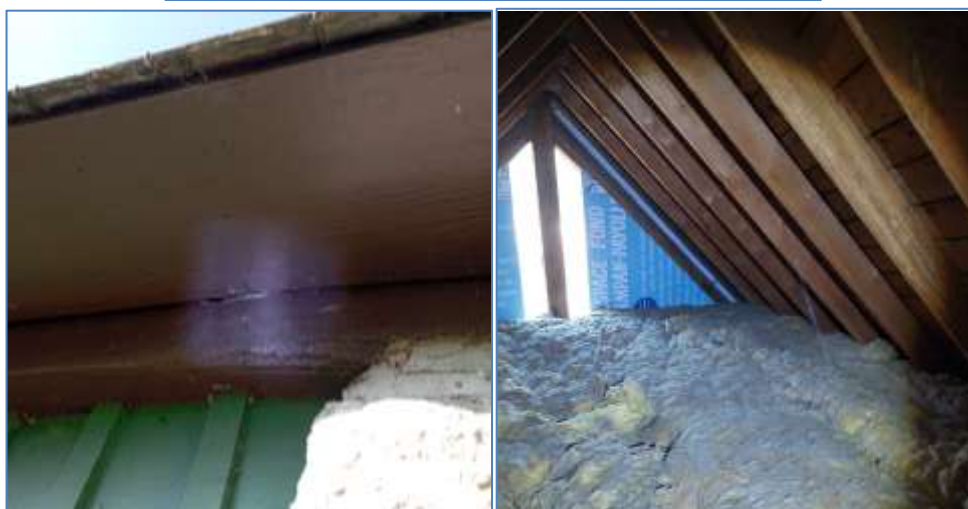
En haut : vue extérieure du bâtiment, à gauche : une des ouvertures laissant un accès aux combles (à droite) Source : AMIDDEV
