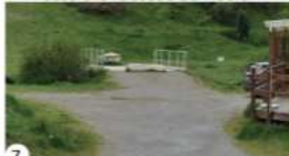
7 Passerelle sur l'Adour
