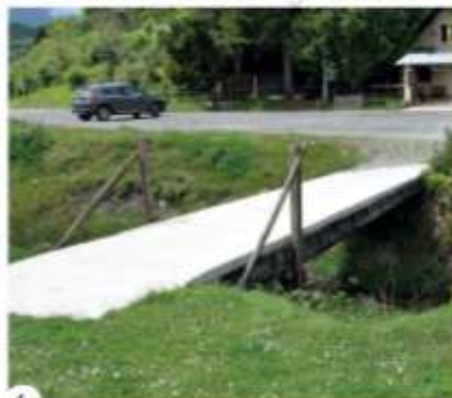
6 Passerelle ruisseau du Hourc
