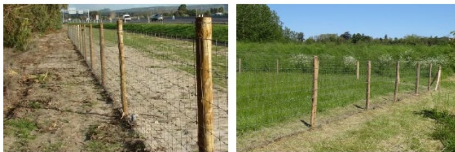
FIGURE 29 : EXEMPLE D'UNE CLOTURE DE PARC SOLAIRE – SOURCE MELVAN
