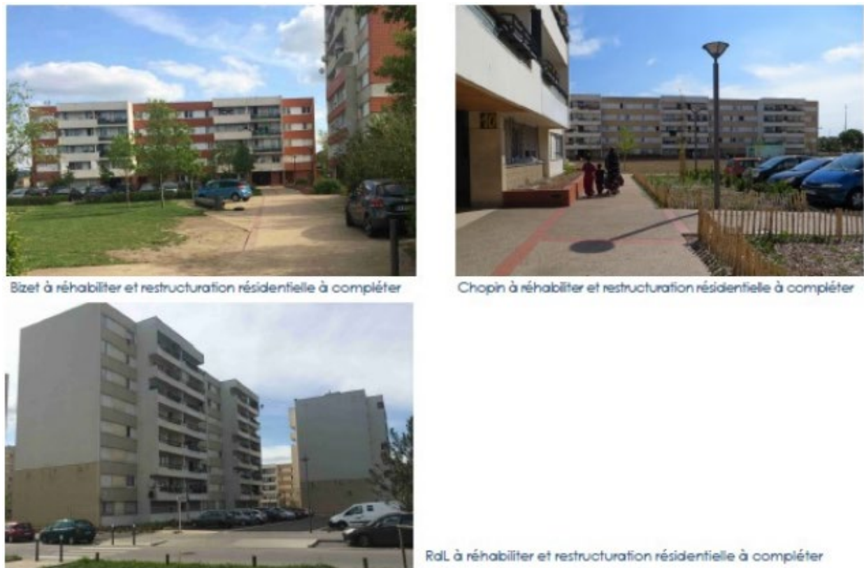
Figure 5 : Quelques photos de bâtiments à réhabiliter (Source : SCUM – Atelier JAM – 2018)
