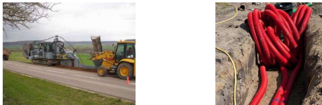
Figure 74 : Illustration des travaux d'enfouissement d'un câble de raccordement le long de la voirie
