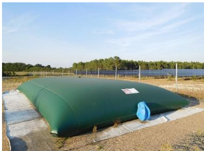
Photo 4 : Exemple d'une bache incendie (Source : EneR Centre-Val de Loire)
