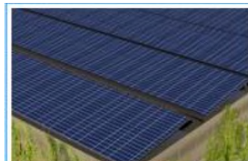
Panneaux photovoltaïques en toiture : Site en autoconsommation 4 106 m 2 d'emprise projetée Hauteur écouit : +16m Hauteur faitage : +16.55 Pentes de 9%, orientées Sud-Est
