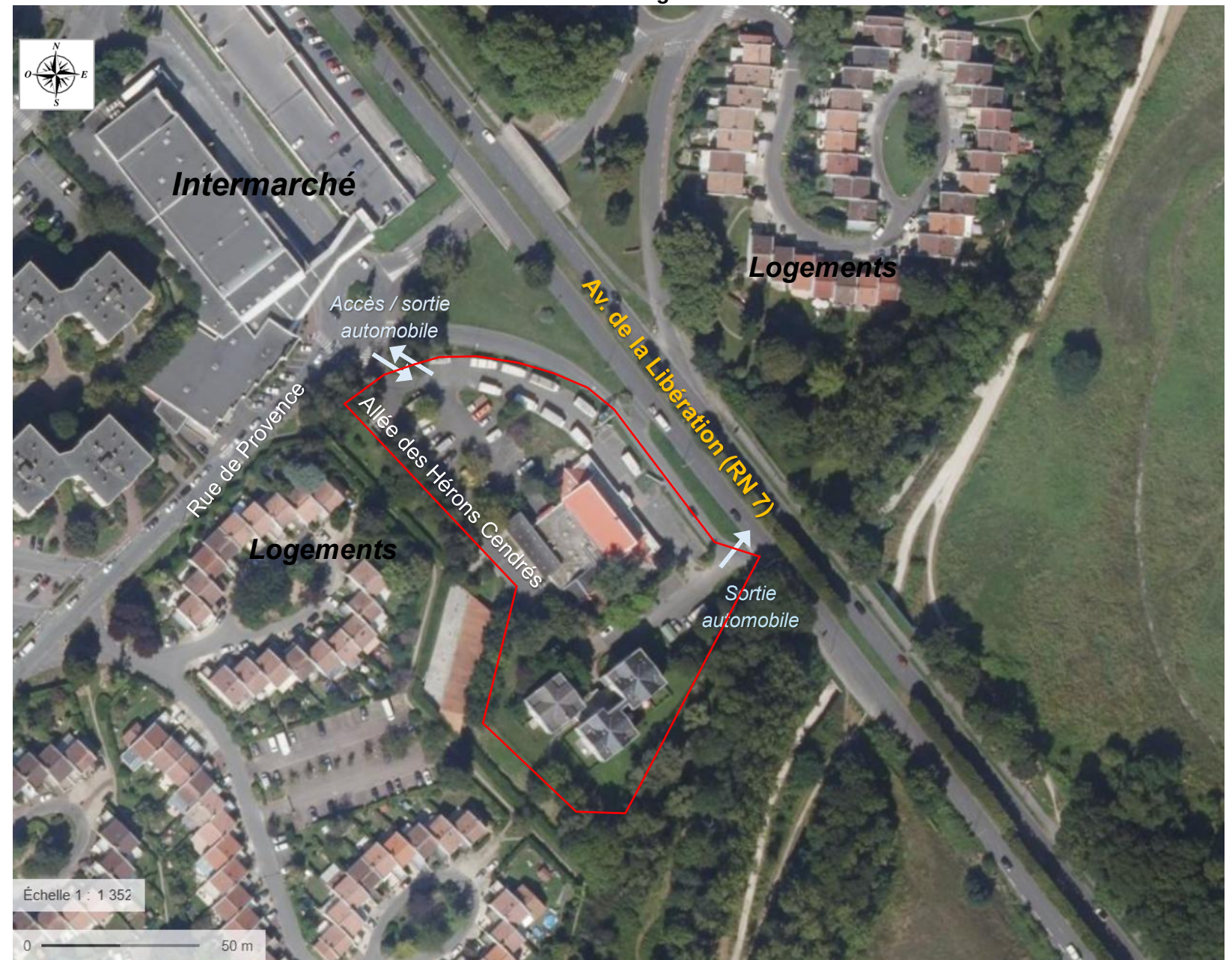
Vue aérienne générale
