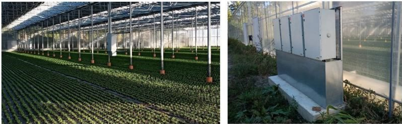
Les coffrets électriques seront protégés et implantés au-dessus de la cote PHE de référence +0,20cm.
