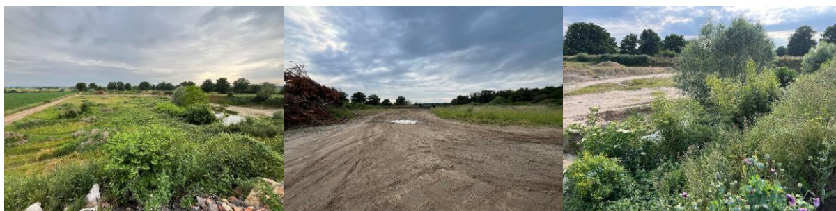
Figure 22 : Plateforme végétalisée (gauche), plateforme vierge (centre), talus végétalisé au sud (droite)
