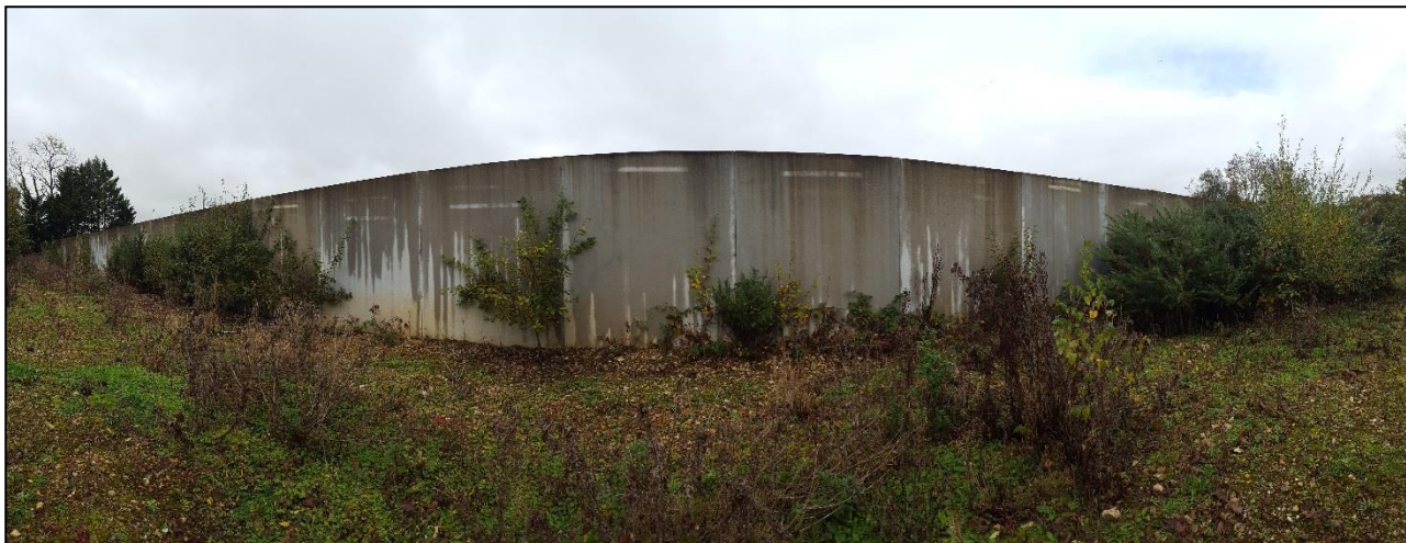
Figure 30 – Photos n° 3 de la bordure sud de la parcelle n° 59 du site de la société VAILLANT RECYCLAGE
