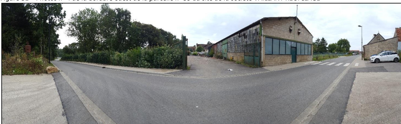
Figure 32 – Photos n° 5 de la bordure ouest de la parcelle n° 336a du site de la société VAILLANT RECYCLAGE
