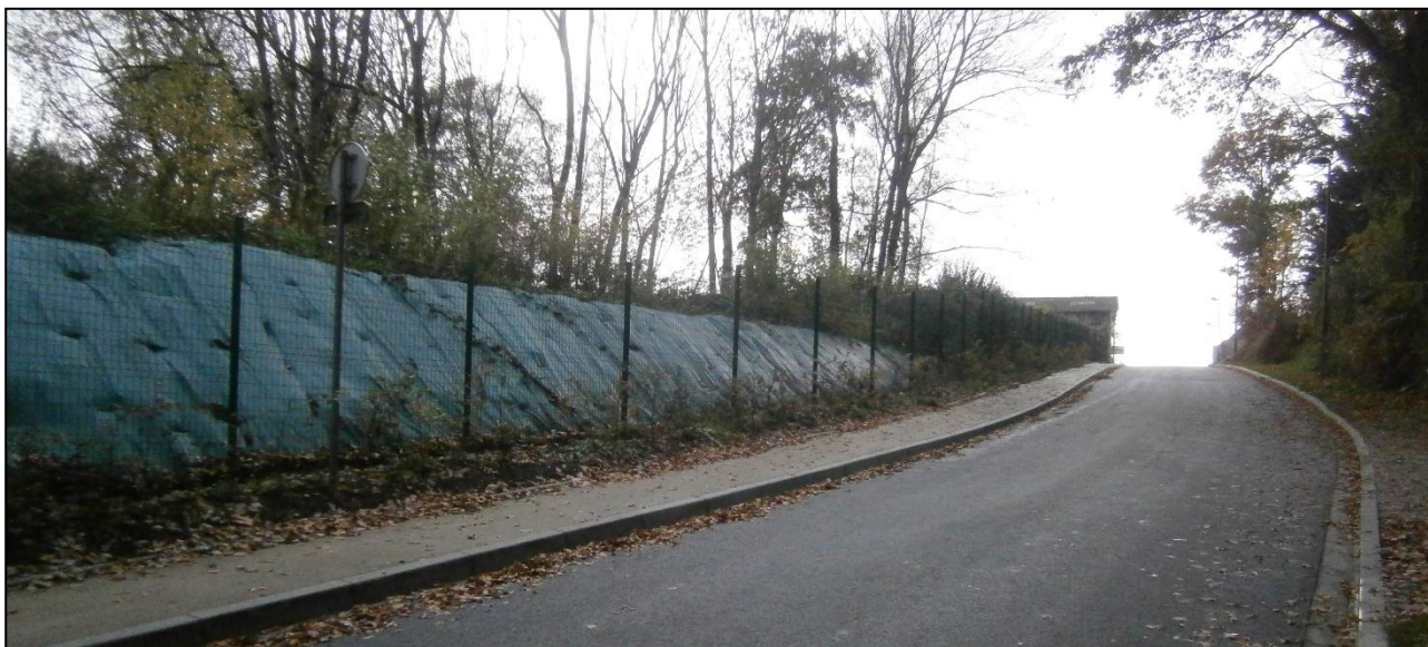
Figure 33 - Photos n° 6 de la bordure sud-est de la parcelle n° 336a du site de la société VAILLANT RECYCLAGE
