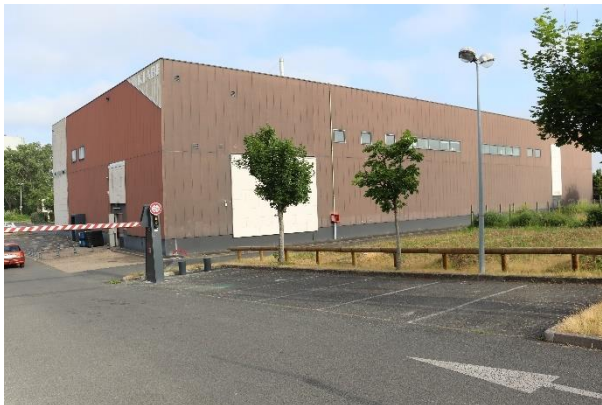
Bâtiment commercial (Kiabi) et parkings - secteur est - Juin 2023
