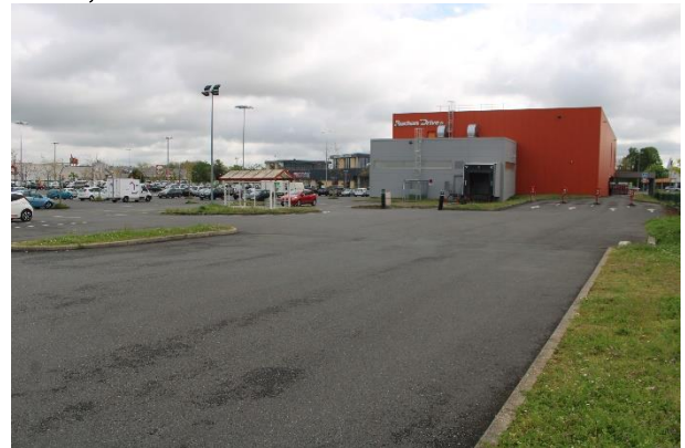
Bâtiment commercial (Auchan drive) et parkings - secteur ouest - Avril 2023
