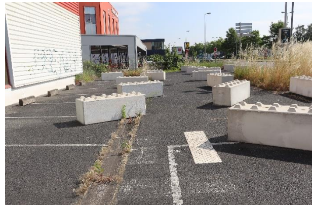
Bâtiment abandonné (ex Saint-Maclou) et parking - secteur ouest - juin 2023
