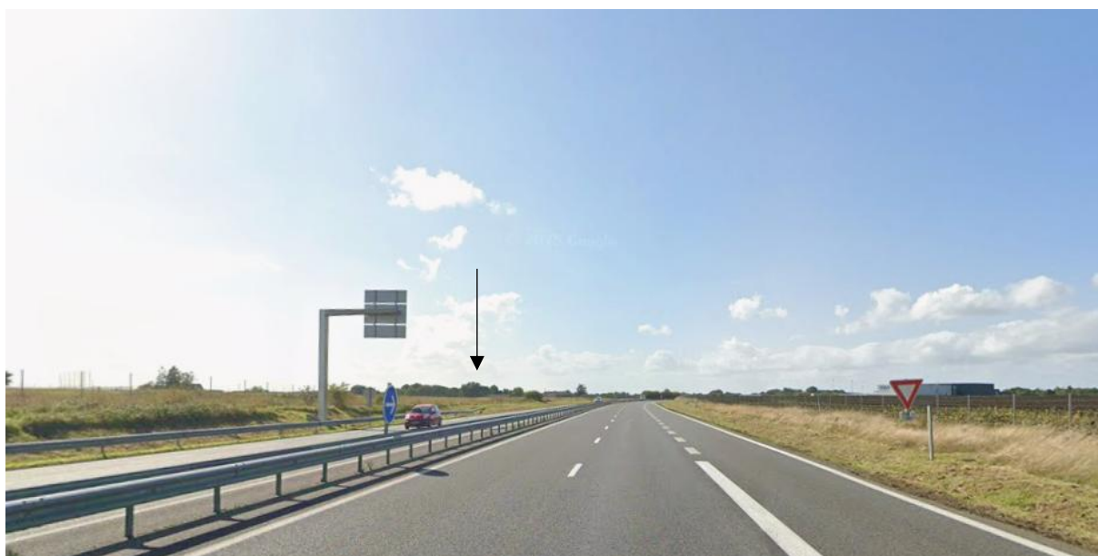
Photographie 6 – Vue depuis la Nationale N147 – 15/10/2025
