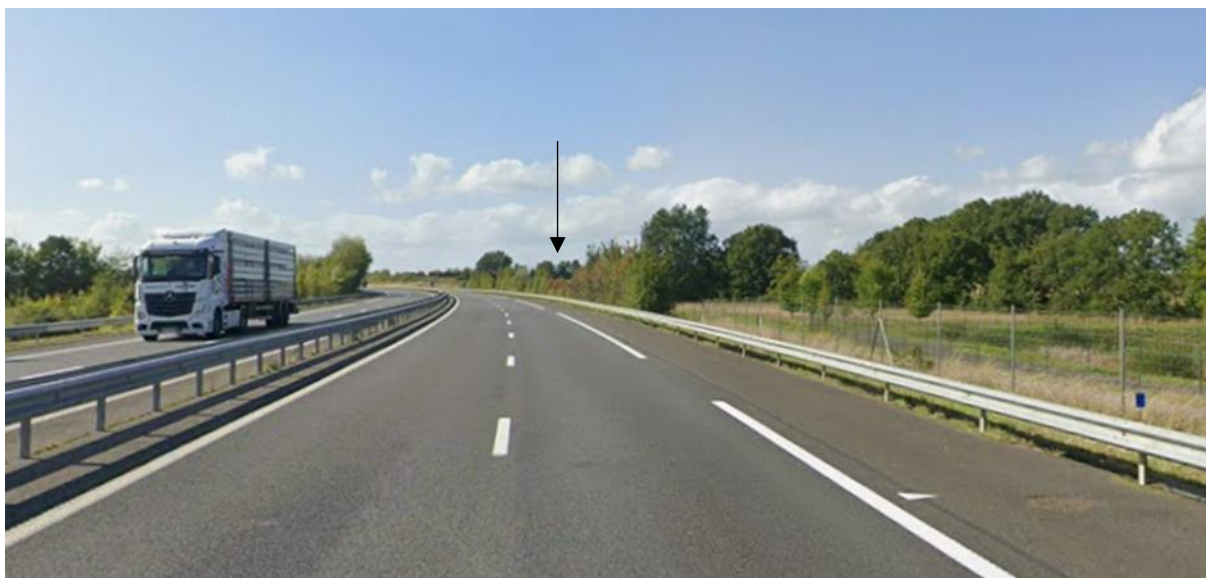
Photographie 6 – Vue depuis la Nationale N147 – 15/10/2025
