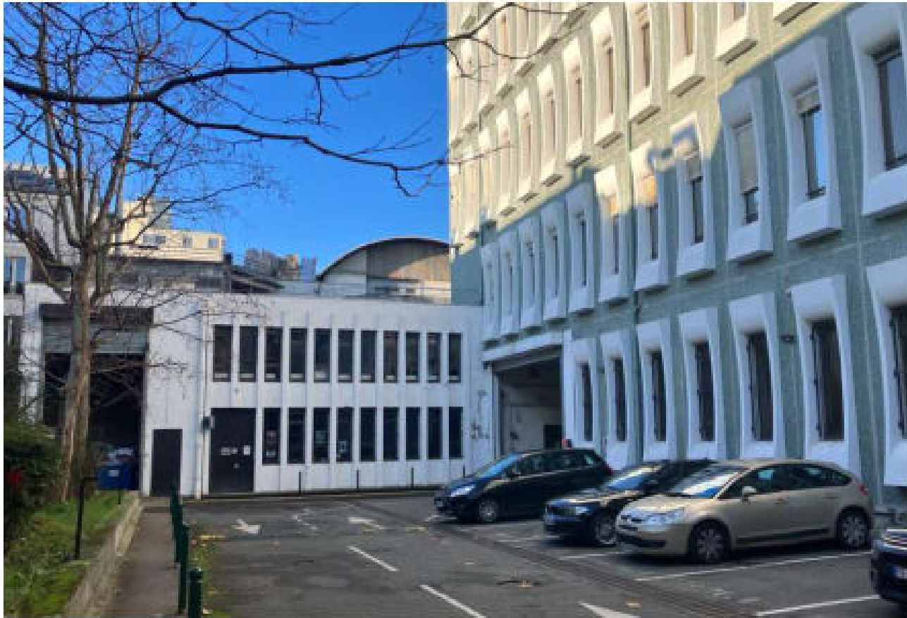
3 Vue du bâtiment F depuis le coeur d'îlot
