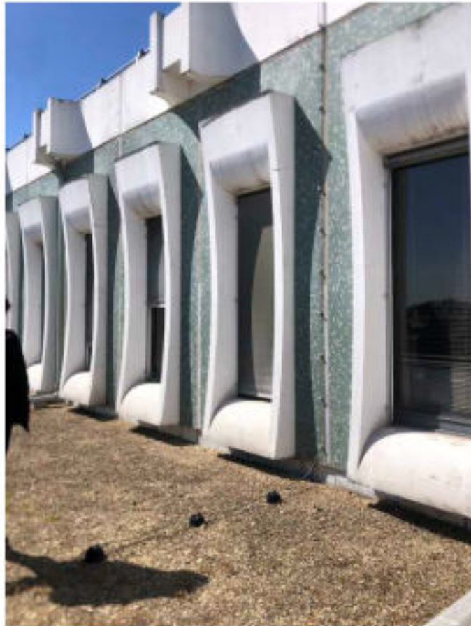
6 Façade de la terrasse du R+5
