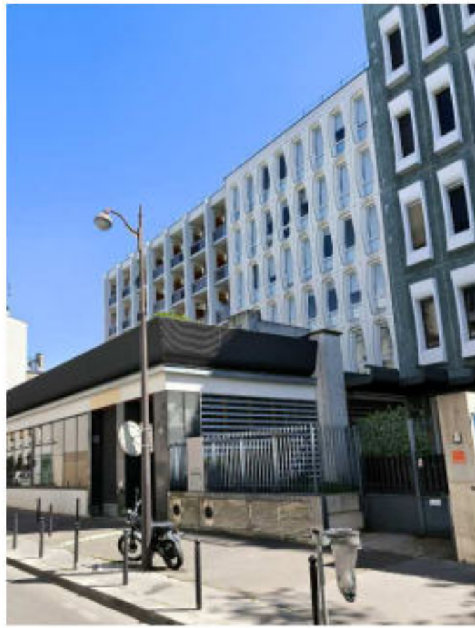
10 Auvent du rez-de-chaussée
