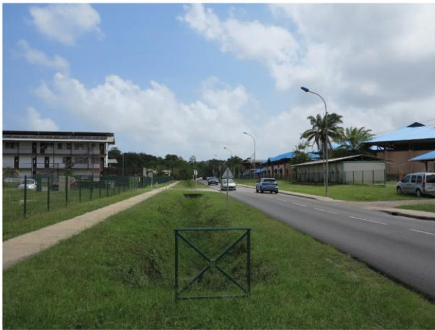
Les fossés/ noues végétales
