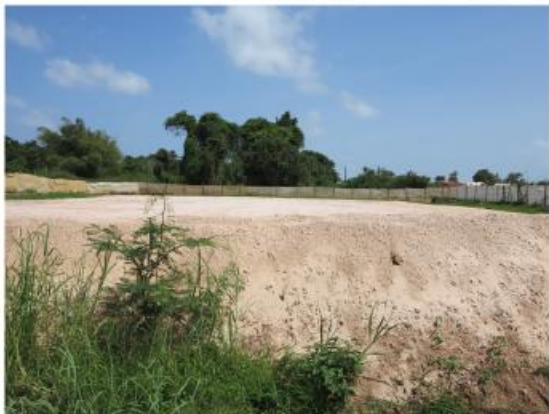
1. Boisement au Sud du Collège Auguste Dédé Site dégradé avec le début des travaux du CDCN
