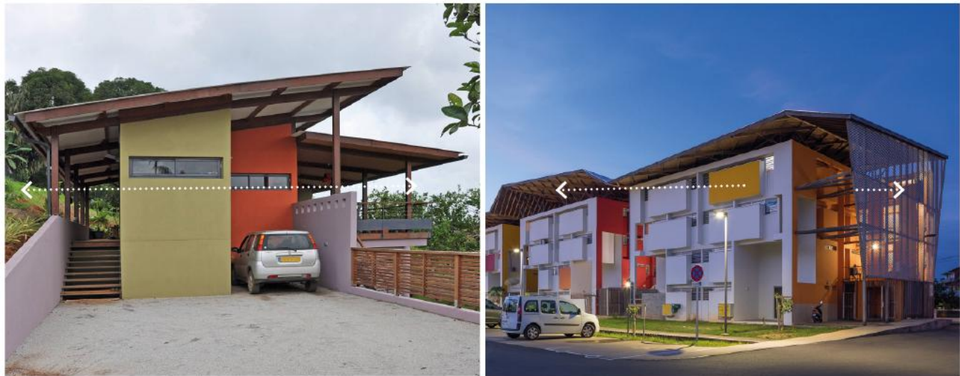
Des logements traversants tant pour l’habitat individuel que pour les logements collectifs
