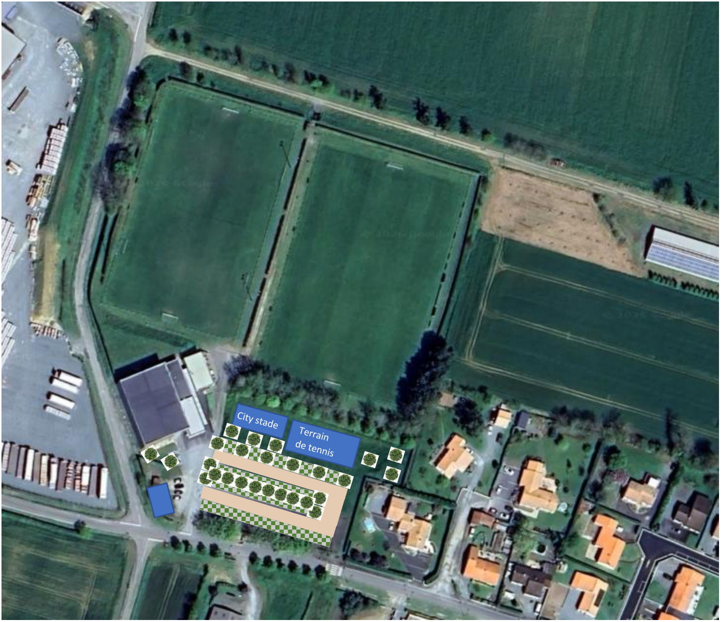
Plan aérien après travaux
