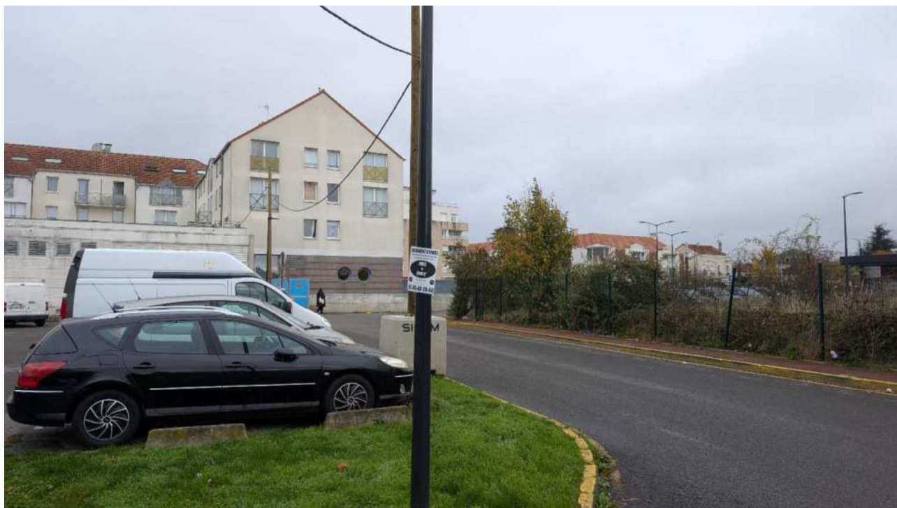
Photographie 10 : Vue des bâtiments localisées au nord-ouest du site
