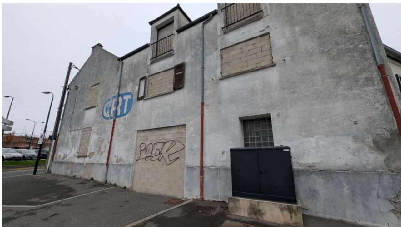
Photographie 7 : Vue des bâtiments abandonnés au sud du site
