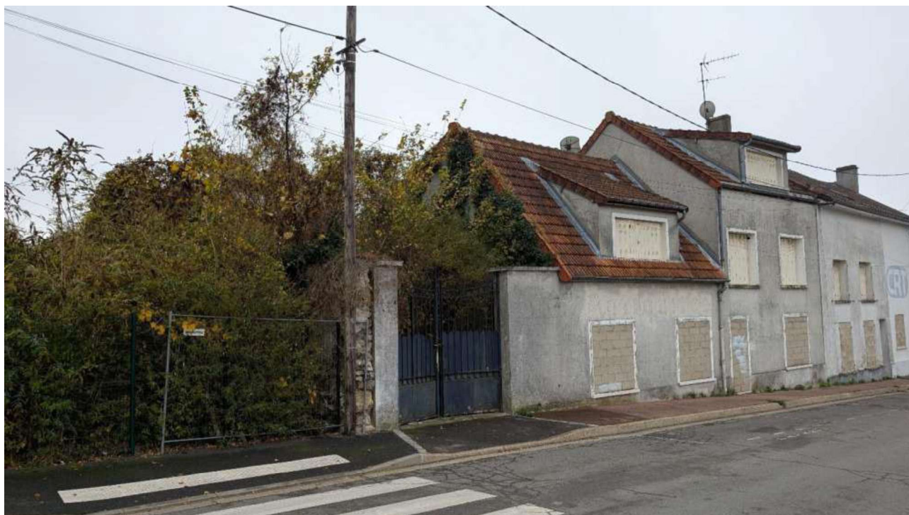
Photographie 8 : Vue de l'accès au site rue des Perriers
