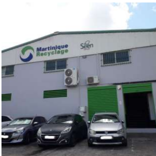
Photo C 2023 > vue proche côté zone d'activité
