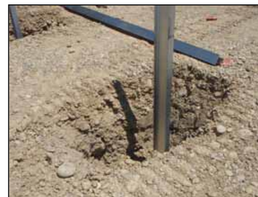
Figure 9 : Types de fondation - pieux battus (Source : Guide MEDDTL 2011 – NCA, 2015)
