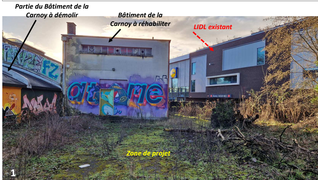
Vue sur l'arrière du bâtiment La Carnoy conservé/réhabilité
