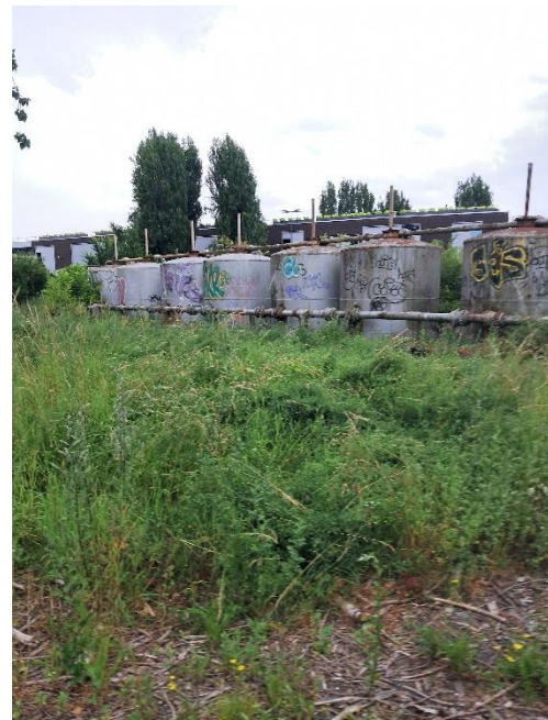
2. Cuves de traitement d'eau
