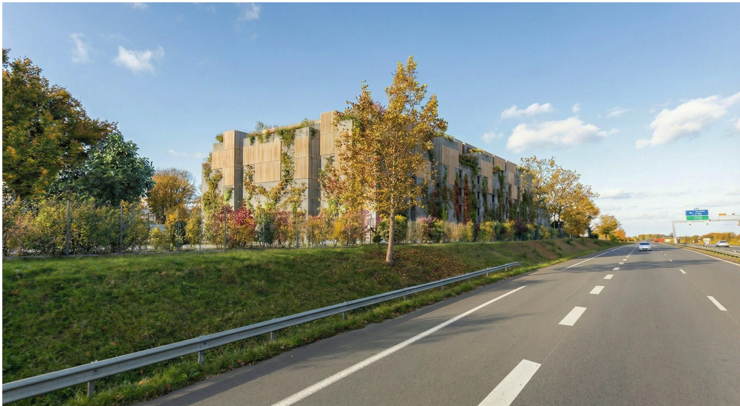
Projet retrait 10m après déconstruction Vue depuis la départementale D962
