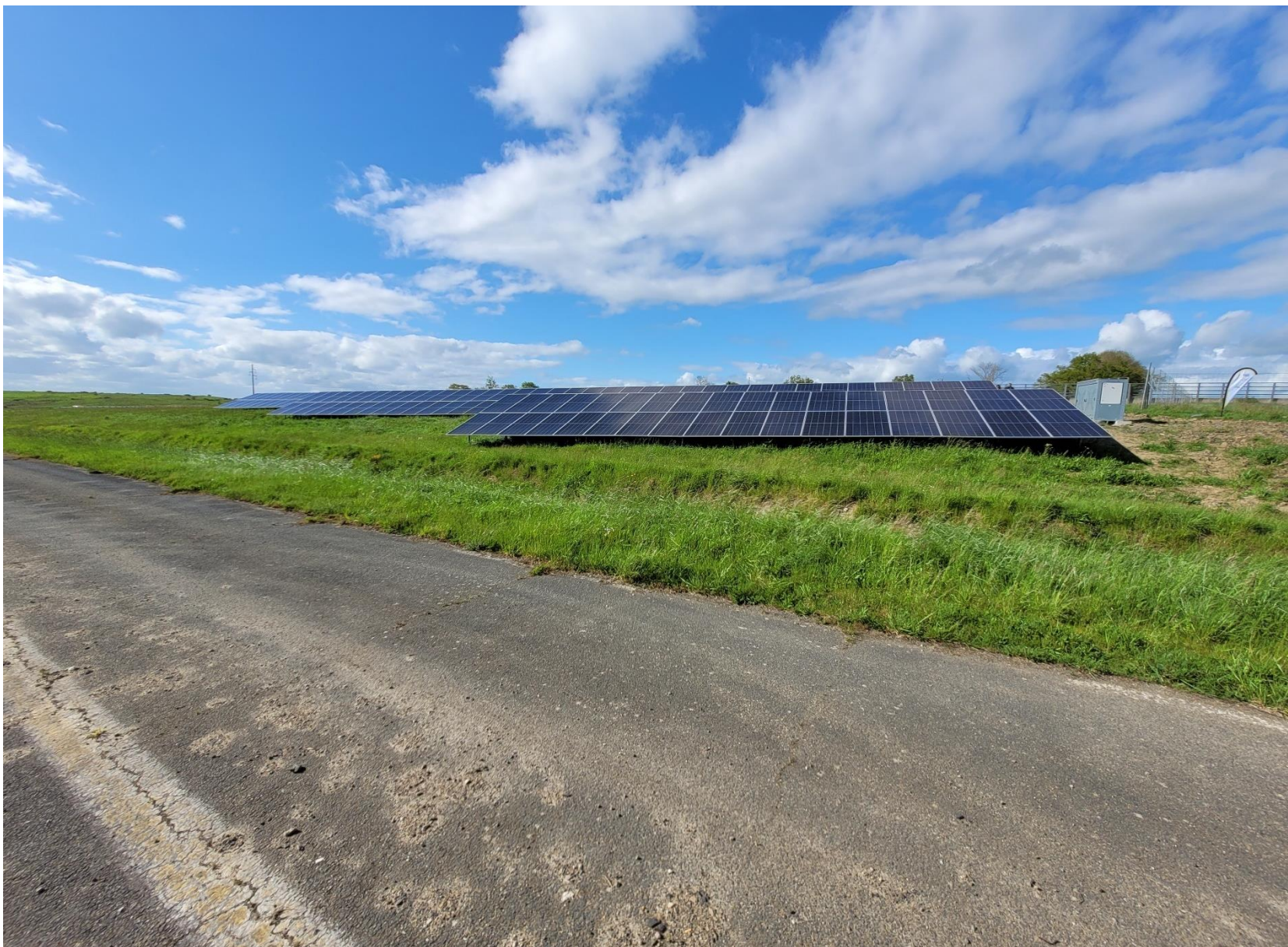
Figure 7 : Photographie 1, Vue depuis l'ancienne portion de RD, avril 2024
