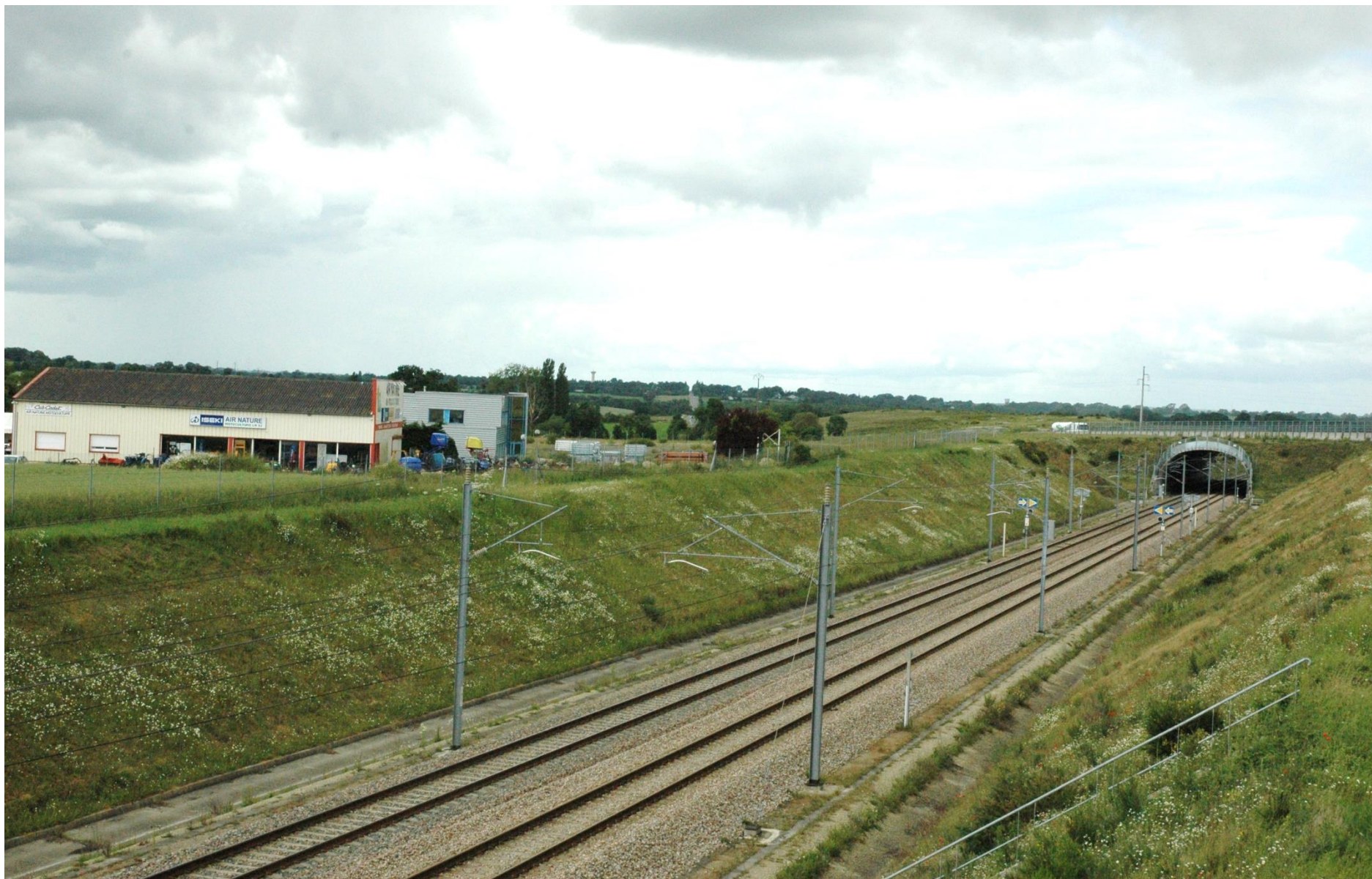
Figure 11 : Photographie 5, Vue depuis l'est du site, mai 2022
