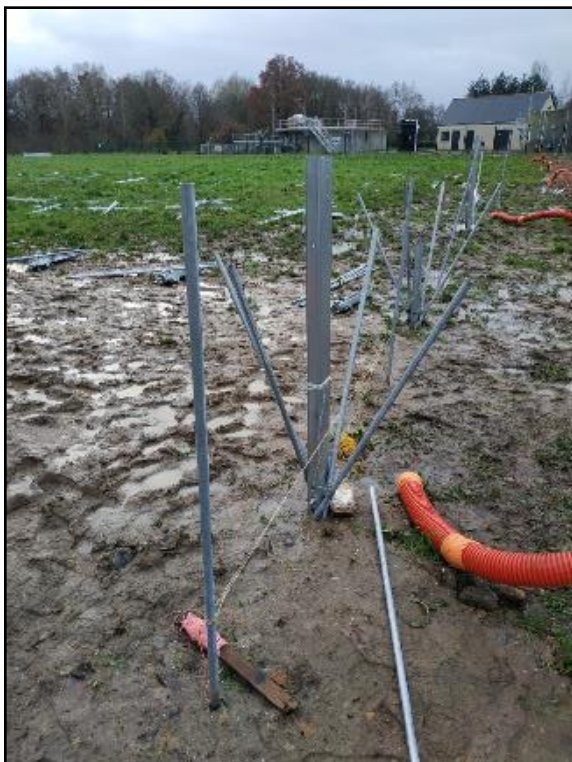
Figure 22 : Structures en micropieux, avant battage des micropieux - Parc solaire de Soucelles - 299 kWc
