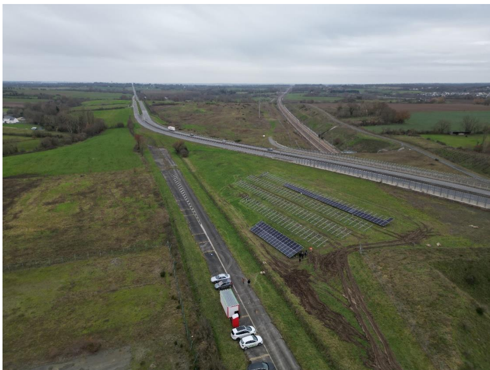
Figure 3 : Vue sur le chantier de construction du PSV de Louvigné – Tranche 1
