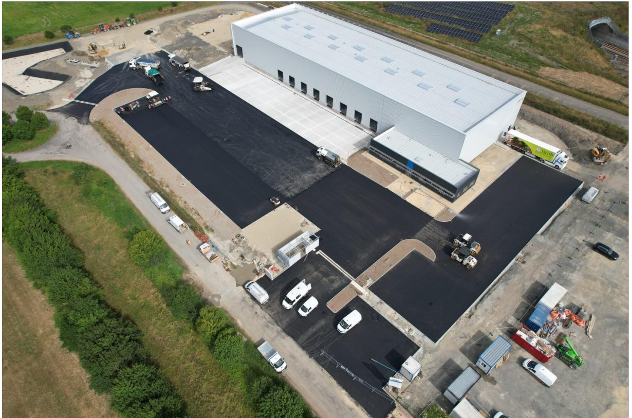
Figure 5 : Vue sur le bâtiment STH et le Parc solaire villageois
