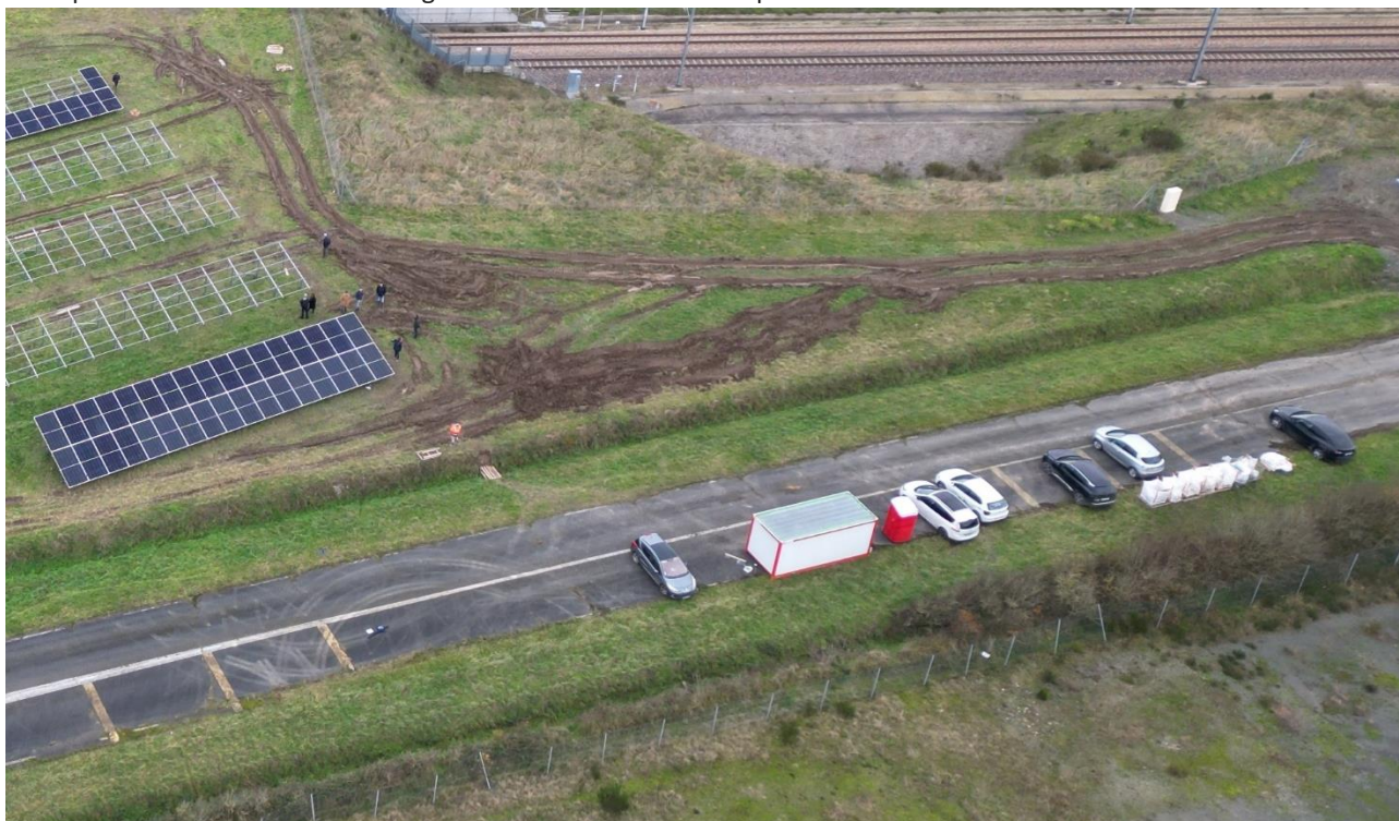
Figure 33 : base vie du chantier de construction de la Tranche 1 (décembre 2023) et espaces de stockage et de tri des déchets
