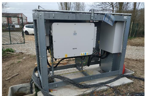
Figure 26 : abri onduleurs
