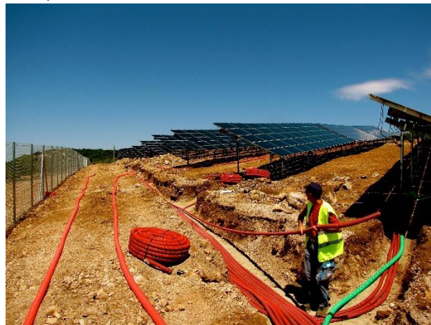
Figure 30 : tranchées internes et gaines
