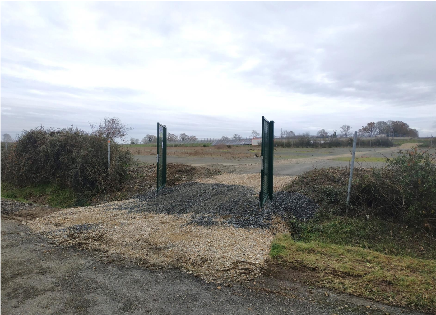
Figure 11 : Photographie 4, Vue depuis l'accès au site par la Zone d'Activités, décembre 2023
