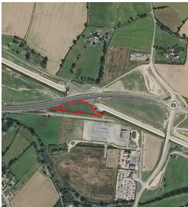
2015 : poursuite des travaux
