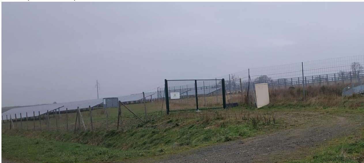
Figure 21 : vue sur le portail d'entrée au site et la clôture périphérique
