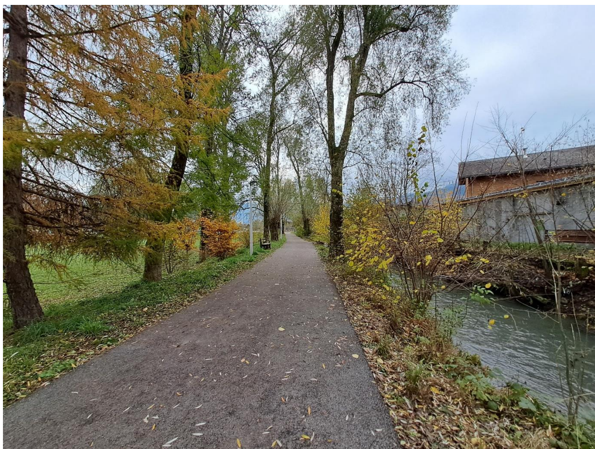
Photo du Système d'endiguement « digue de l'Hopital » à Sallanches
