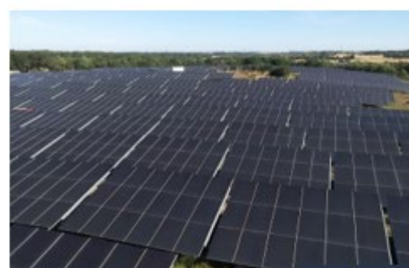
Parc solaire Mésanger (44) Développement, Financement, Construction et Exploitation ISDND
