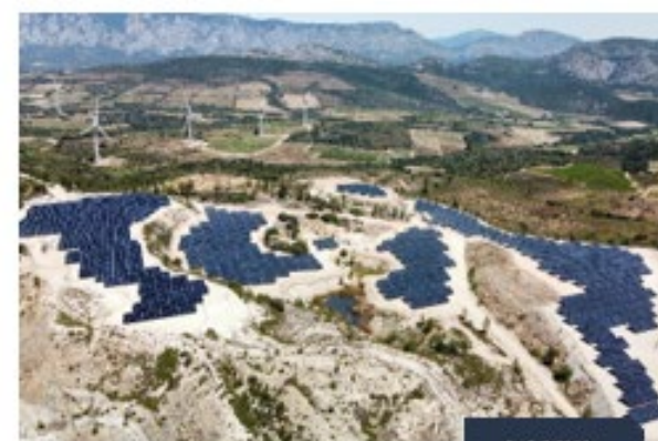
Parc solaire Lansac (66) Développement, Financement, Construction et Exploitation Ancienne carrière
