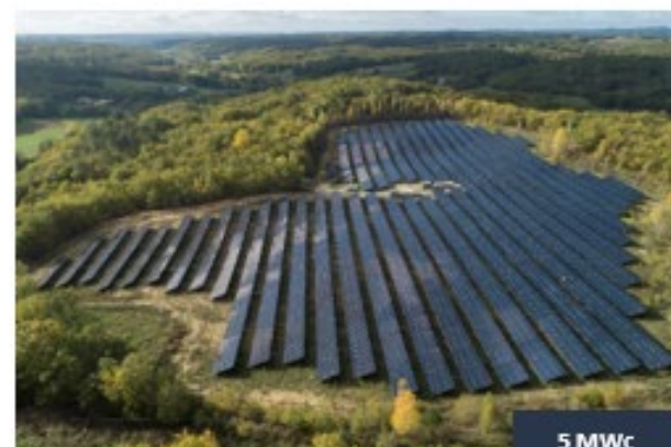
Parc solaire Lisle sur Tarn (81) Développement, Financement, Construction et Exploitation Ancienne carrière
