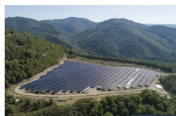
Parc solaire Graissessac (34) Développement, Financement, Construction et Exploitation Ancienne mine
