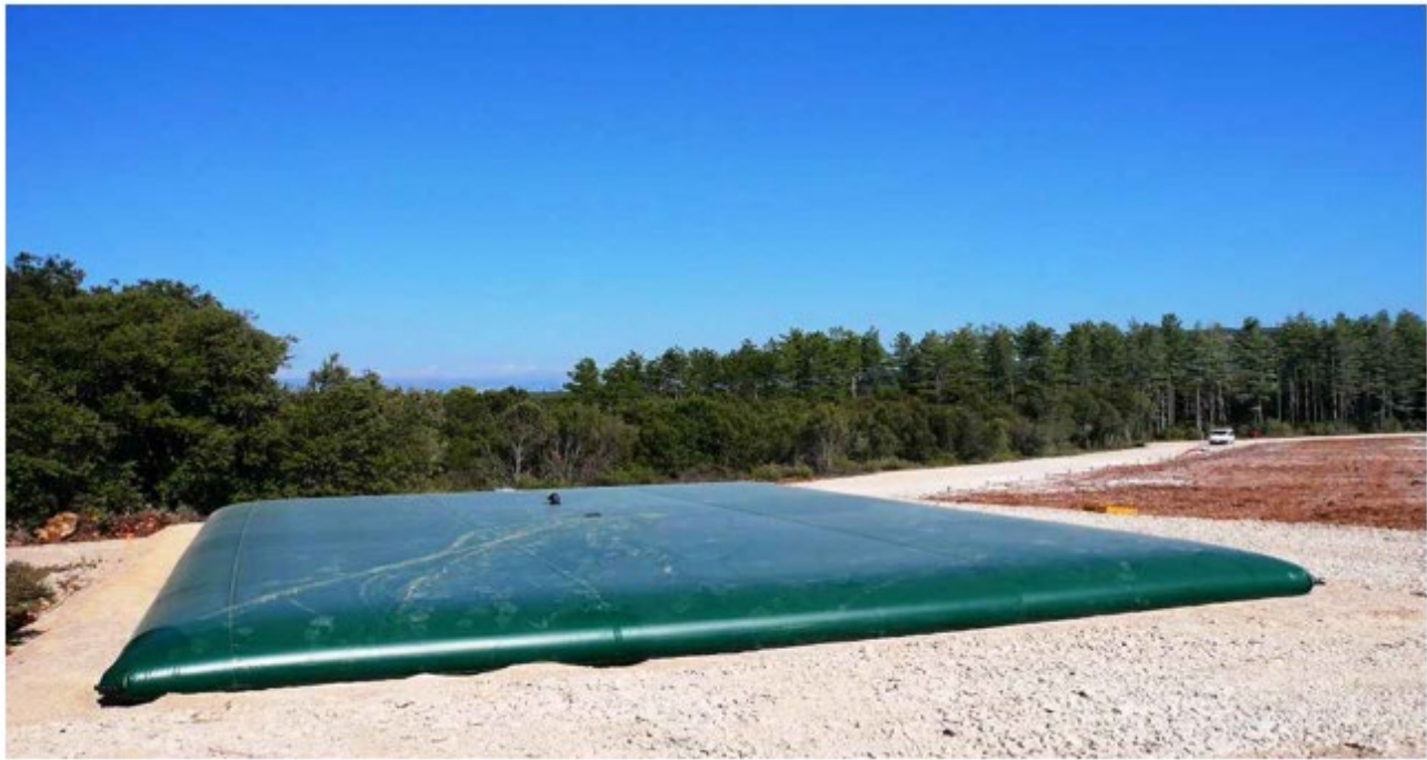
Figure 11 : exemple d'une citerne (Source : URBASOLAR, 2023)
