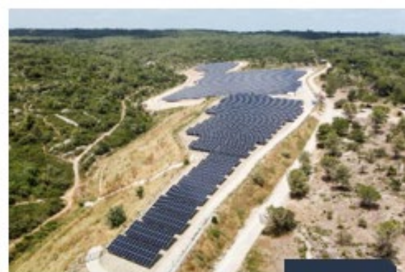
Parc solaire Caveirac (30) Développement, Financement, Construction et Exploitation Ancienne décharge
