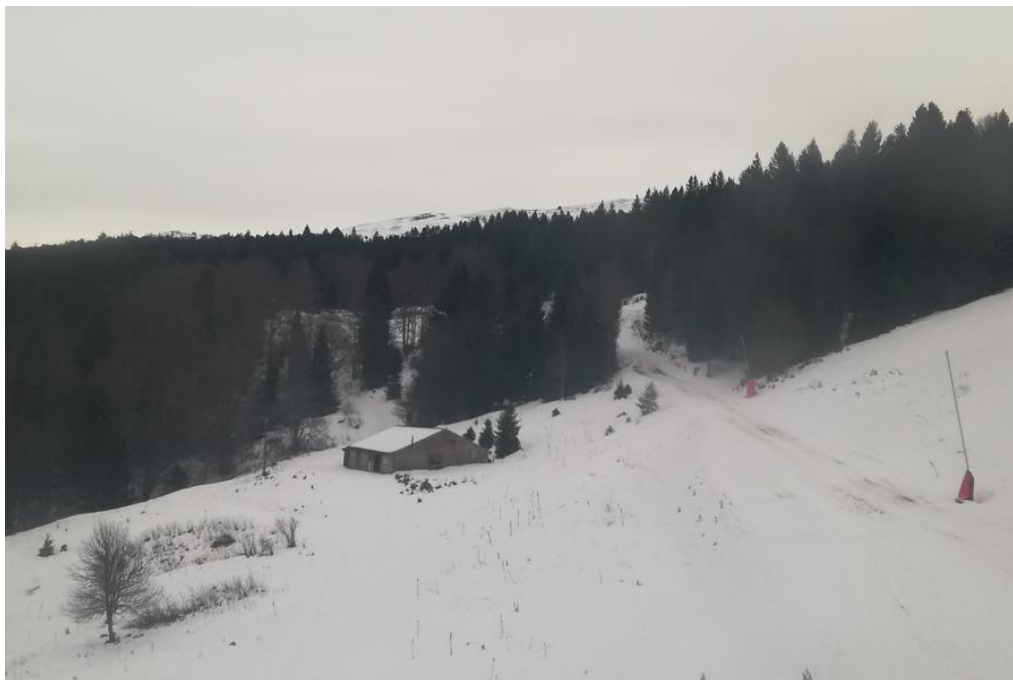
Bâtiment existant inutilisé pouvant être réutilisé comme un point de restauration (photo prise depuis la télécabine de la Catheline).
