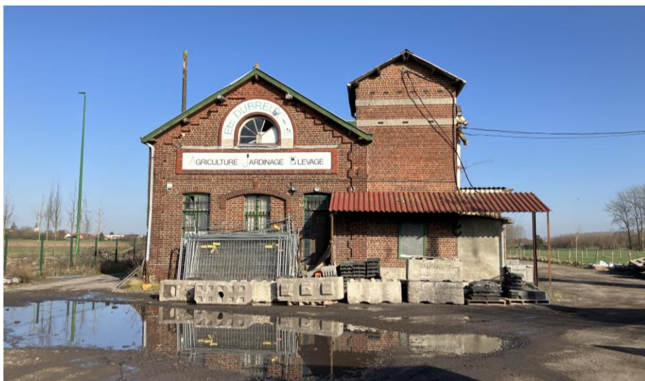
Friche DUBREUX (bâtiment) – Mars 2026
