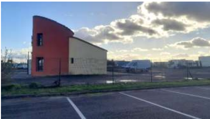
Vue de la boulangerie depuis le foncier amont
