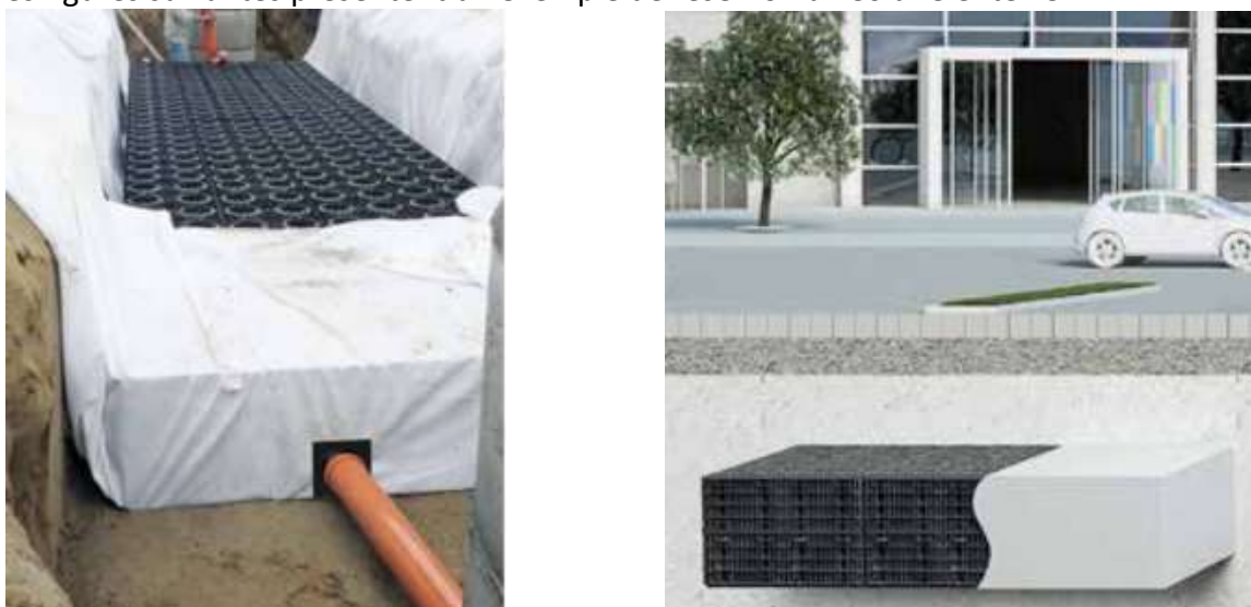
Figure 20 : Exemple de réservoir alvéolaire infiltrant
