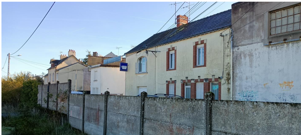
Habitations au Sud du site d'étude.
