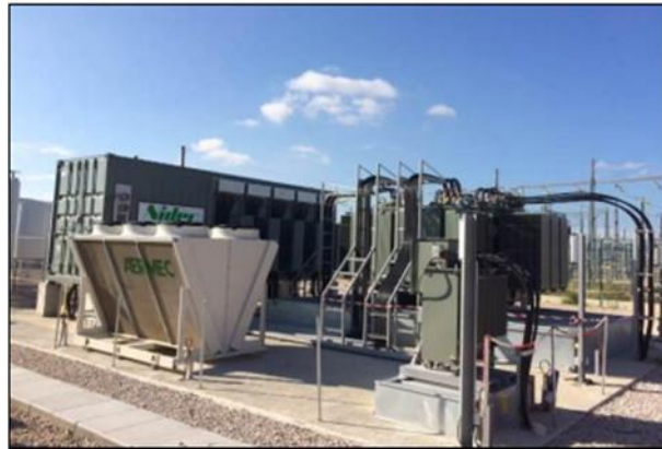
Exemple de système de compensation
