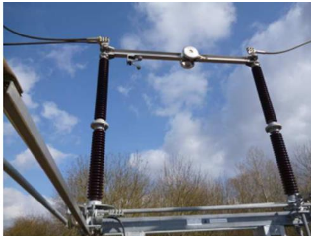
Exemple de sectionneur
