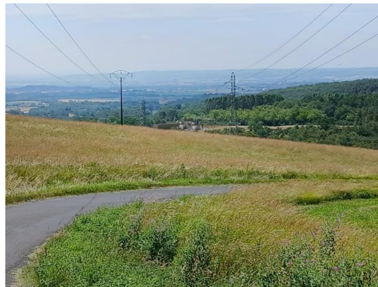
Intégration du poste électrique (vue lointaine)
