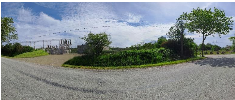
Intégration du poste électrique – vue Ouest
