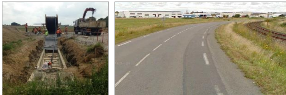
Déroutage d'un câble souterrain au niveau d'une jonction (à gauche) et réfection d'une chaussée après travaux (à droite)
