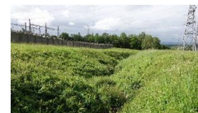
Ruisseau temporaire rectifié près du poste
