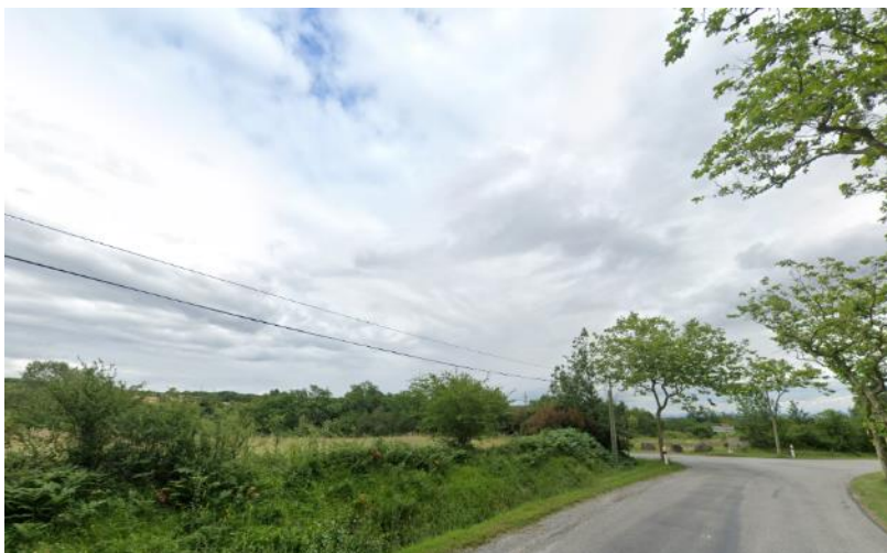
Vue du site sur la gauche depuis la route départementale D642Z – Source : Google Maps
