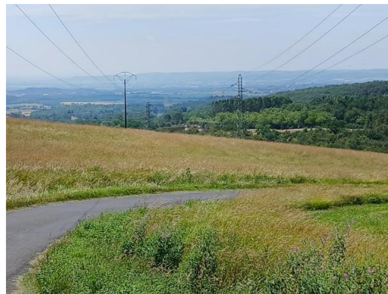
Intégration du poste électrique avec haie (vue lointaine)
