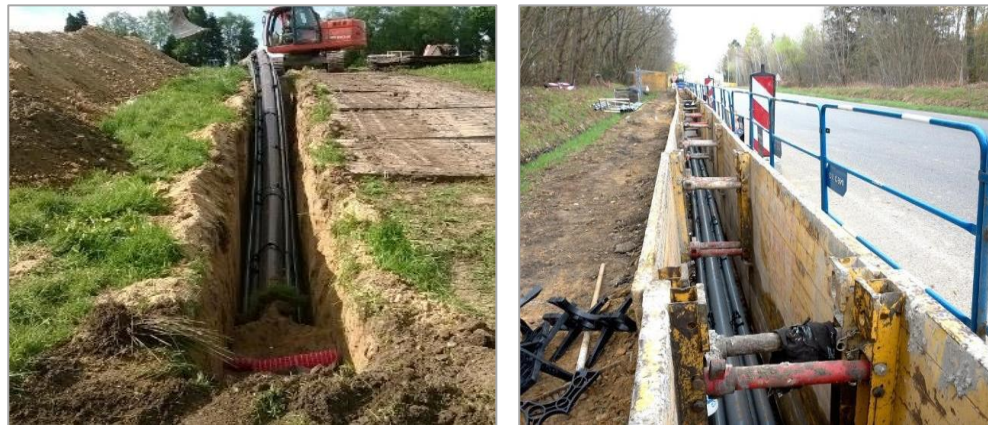
Pose des fourreaux PEHD en milieu rural et PVC en bordure de voirie
